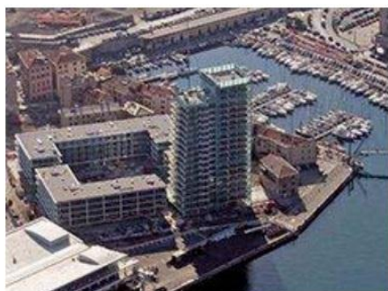
Ristrutturazione dell'ex Darsena di Savona
